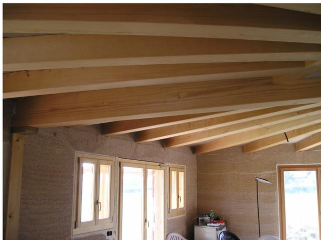
FIG. 4 – Intérieur d'une maison en chanvre avec sa structure en bois.
